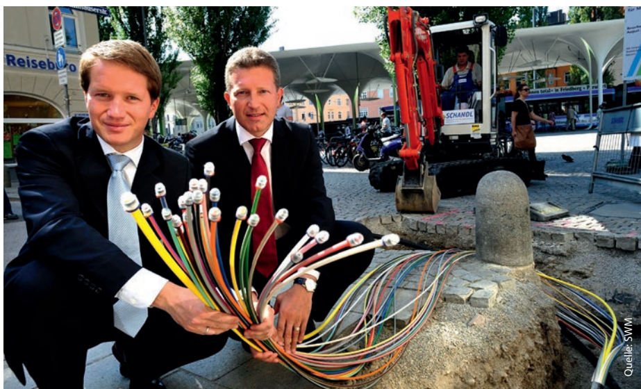
Dr. Florian Bieberbach, Vorsitzender der Geschäftsführung der Stadtwerke München GmbH, und Jens Prautzsch, Sprecher der Geschäftsführung bei M-net, zeigen sich auf einer Baustelle in der Haimhauserstraße inmitten von Schwabing begeistert.
