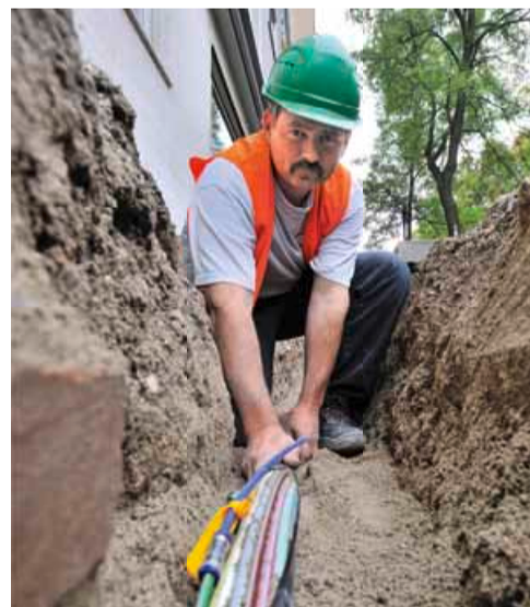
Beim Ausbau der Glasfaser-Infrastruktur in München kooperiert M-net mit den Stadtwerken München.
