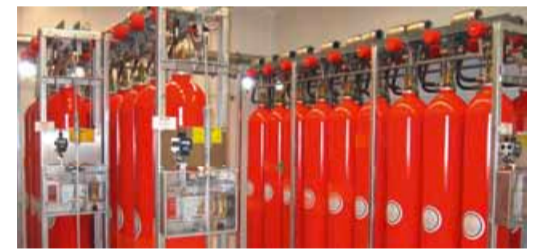
Blick in die Löschmittelzentrale eines M-net Housing-Centers
