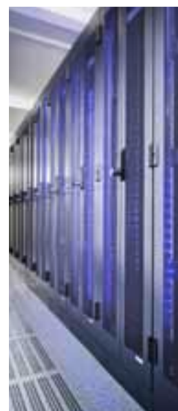
Neues Rechenzentrum in Augsburg: M-net erweitert Kapazitäten.
